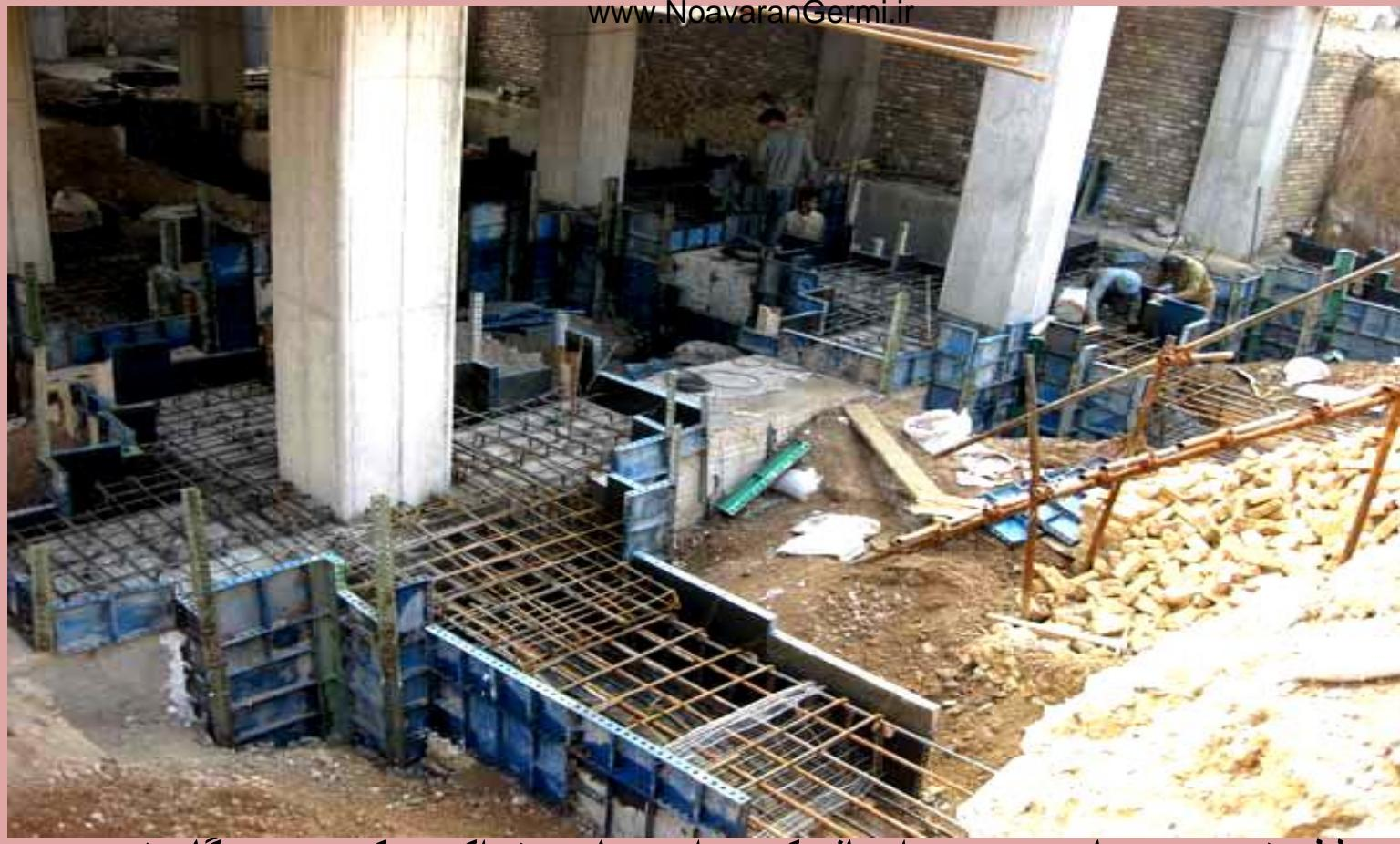
بدلیل بتن ریزی نا مرغوب و اضافه کردن اب زیاد به تراک میکسر به هنگام بتن ریزی و عدم کنترل آن موجب گردید تا مقاومت بتن کاهش شدیدی پیدا کرده و در نتیجه فونداسیون این پروژه دچار اشکال گردد. با توجه به نتایج آزمایشات بعمل آمده که مبنی بر مقاومت پایین بتن می باشد نسبت به مقاوم سازی اقدام گردید. در این روش با افزایش ظرفیت بار بری سطح پی با تعریض نمودن نوارهای طولی اقدام گردید. مهمترین مسئله تامین مقاومت بر شی ما بین لایه های بتن قدیم و جدید می بود، که با کاشت میلگرد و ایجاد بر شگیر هایی تامین گردید.
