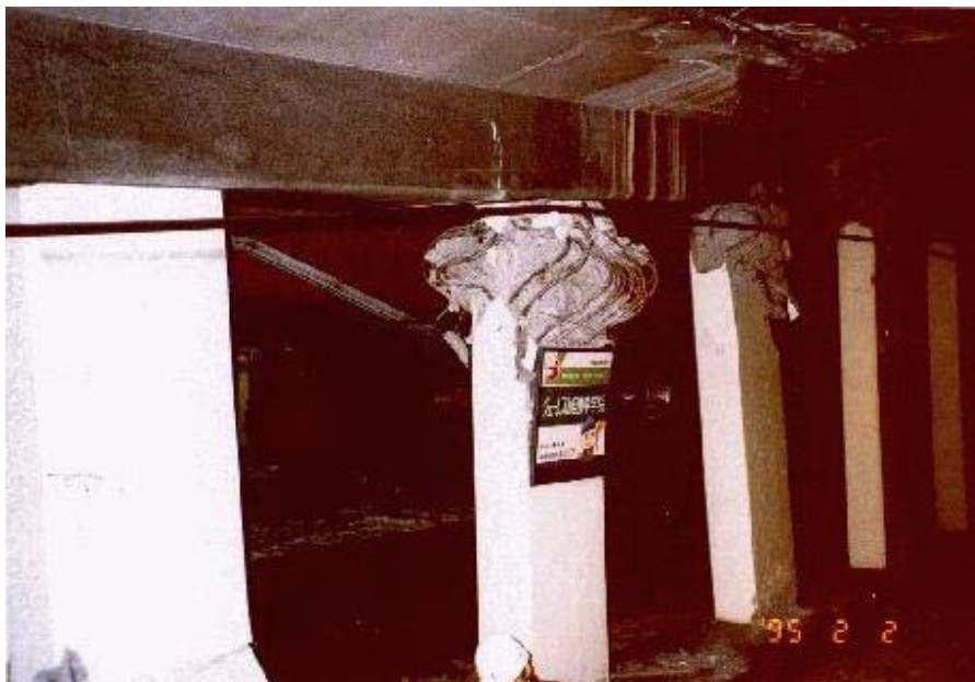
شکل ۲ نمایی از خرابی ستونهای میانی
