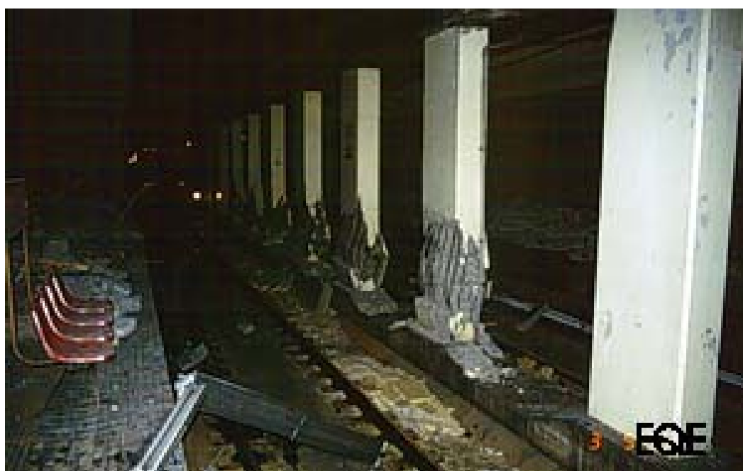
شکل ۳ نمایی از خرابی ستونهای میانی
