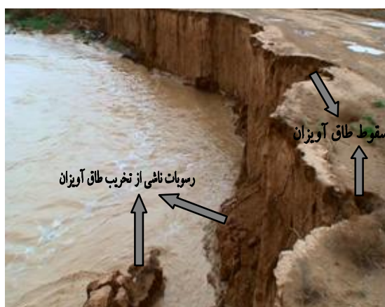
شکل 2- تخریب طاق‌های آویزان تشکیل شده در سواحل رودخانه کردان: (راست) پس از وقوع سیلاب مورخ 22 اسفند 1386 (بده پیک سیلاب در ایستگاه نجم آباد 12/15 مترمکعب در ثانیه)، (چپ) هنگام وقوع سیلاب مورخ 10 اردیبهشت 1388 (بده پیک با دوره بازگشت دو ساله معادل 18/4 مترمکعب در ثانیه)
