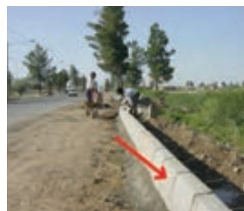
▲ شکل ۳-۳۱ جدول مانع عبور با شیب داخلی
