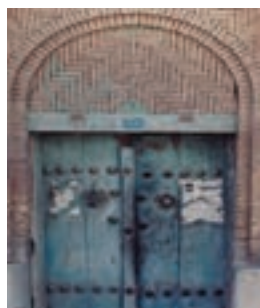
▲ شکل ۴-۷ کاربرد قوس در نعل درگاه
