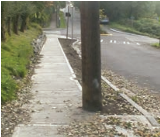
▲ شکل ۳-۴۰ به کارگیری قطعات مجزا در کف‌سازی
