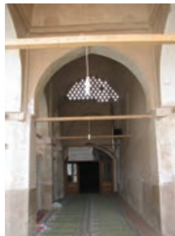
▲ شکل ۴-۷۲ کاربرد چوب در ساخت قوس‌ها
