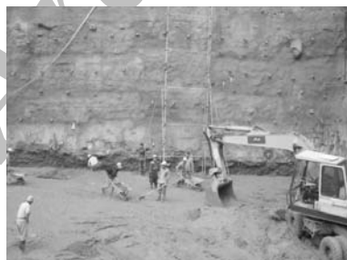
تصویر ۱۶- روش میخ کوبی - مشکلات اجرایی بالا بودن سطح آب زیر زمینی. (ماخذ: نگارنده)
