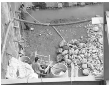
تصویر ۱۷- روش میخ کوبی - حفره چاه زهکشی در کف گود. (ماخذ: نگارنده)
