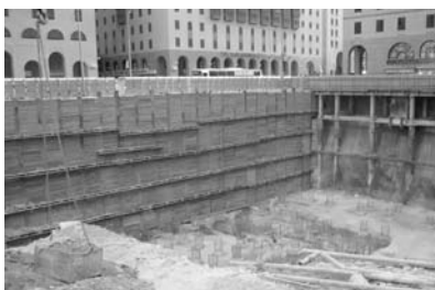
تصویر ۱۰- پایدار سازی جداره گودبرداری از خارج گود- روش میخ کوبی. (مأخذ: نگارنده)
