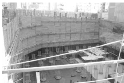
تصویر ۹- پایدار سازی جداره گودبرداری از خارج گود به روش شمع و انکراژ. (مأخذ: نگارنده)
