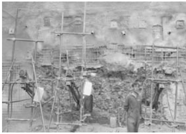
تصویر ۱۳- روش میخ کوبی - حفاری نیل ها. (ماخذ: نگارنده)
