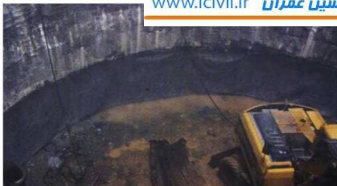
استفاده از Enkadrain در شفت مترو تهران
