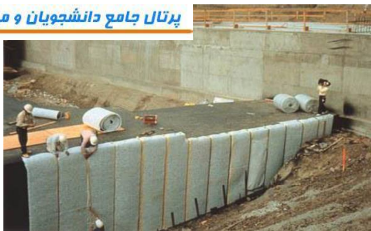
استفاده از Enkadrain در شفت مترو تهران
