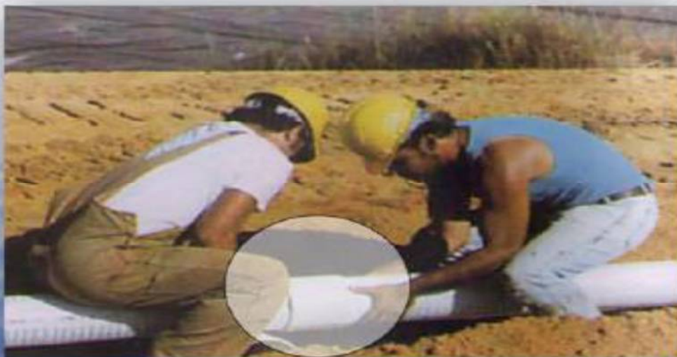
نمونه اتصال گوبلینگ ساده با سهولت در نصب
