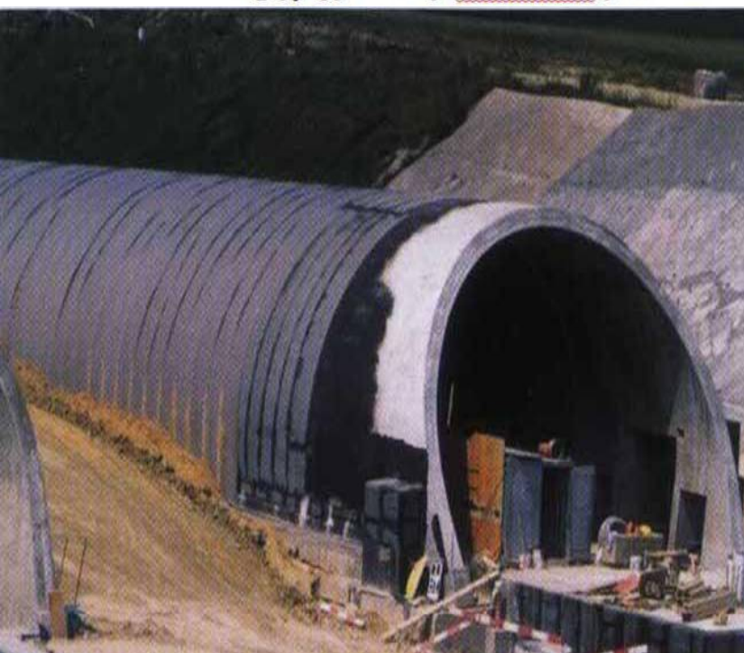
استفاده از Enkadrain در شفت مترو تهران
