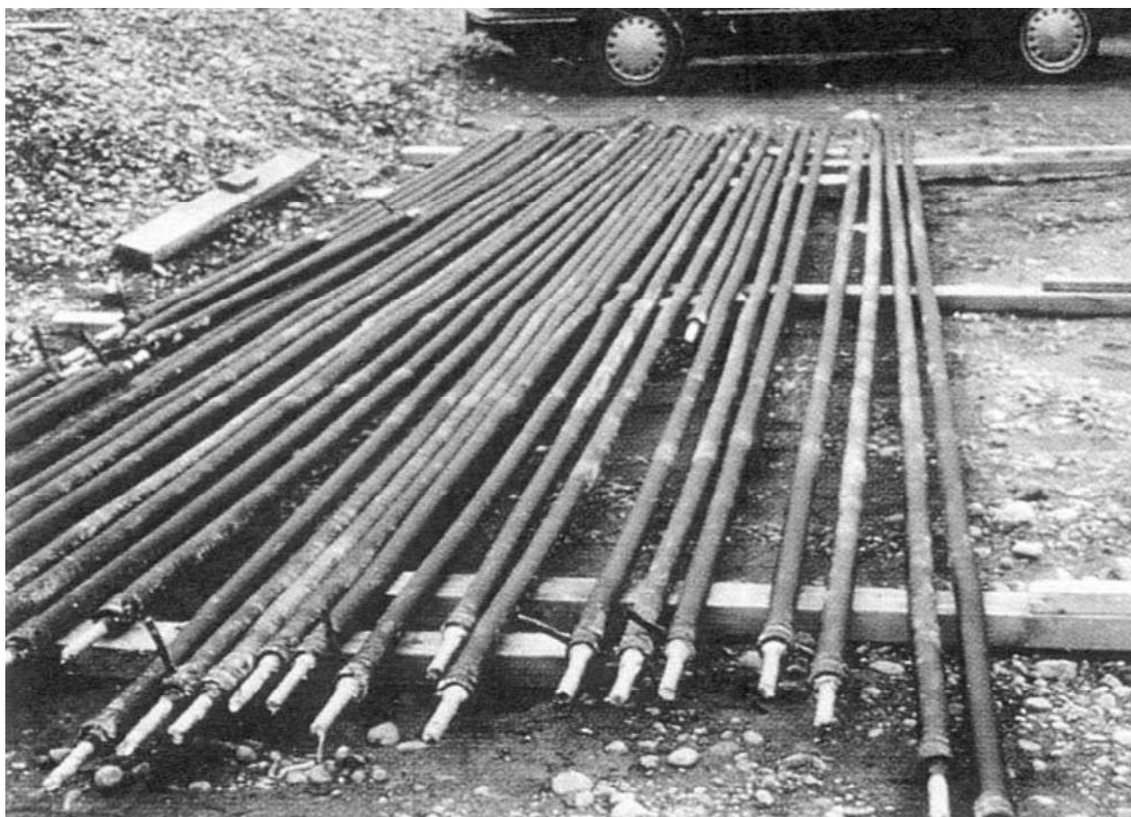
شکل ۴-۴: میلگرد ها (با رنگ روشن در انتهای میخ) با غلاف (رنگ تیره) به صورت کپسول درآورده شده اند، پیش از نصب میخ ها.
