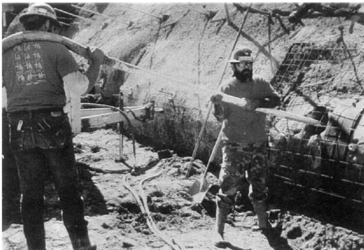
شکل ۲-۴: دوغاب ریزی از طریق لوله (تریمی).
