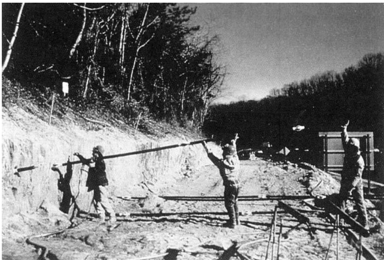
شکل ۴-۶: برداشت ابتدائی گود و نصب میخ.
