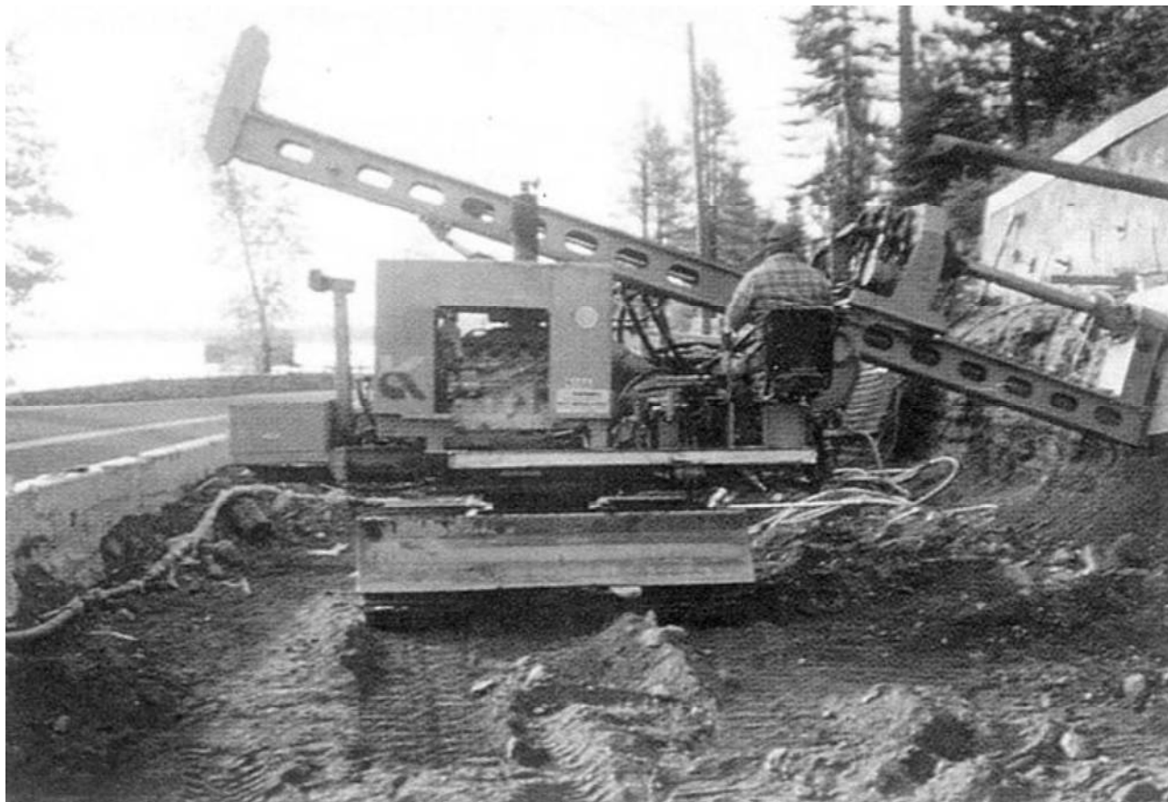
شکل ۸-۴: مته کاری برای میخ توسط روش چرخشی.
