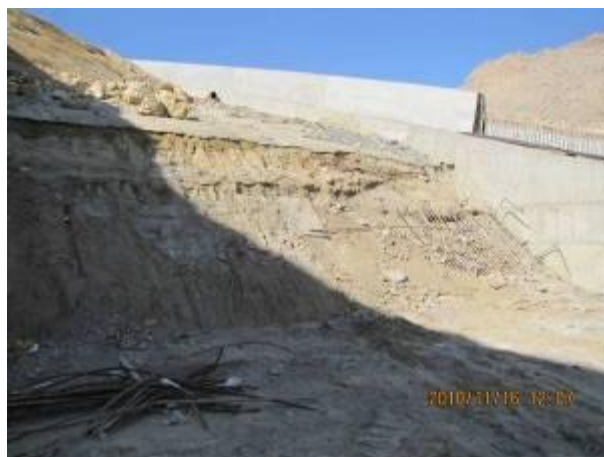
تصویر شماره ۱۵: جناح راست سرریز و الزام ساماندهی و پایدار سازی آن
