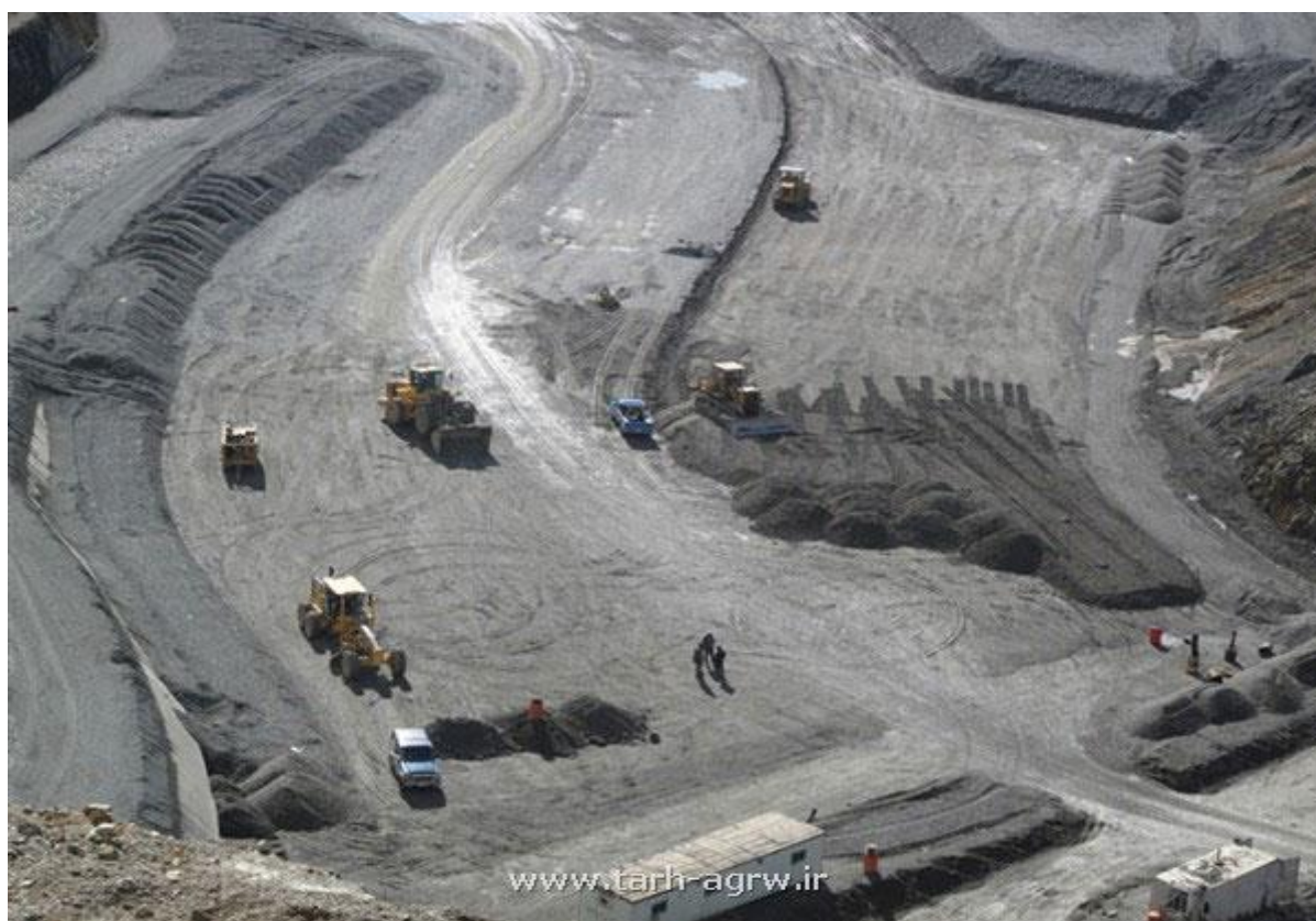
نمایی از سد سیلوه در مراحل اولیه خاکریزی و اجرای پروژه
