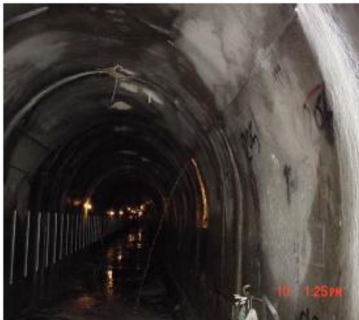
تصویر شماره ۲: گالری زهکش و نشت به علت عدم تکمیل تزریق
