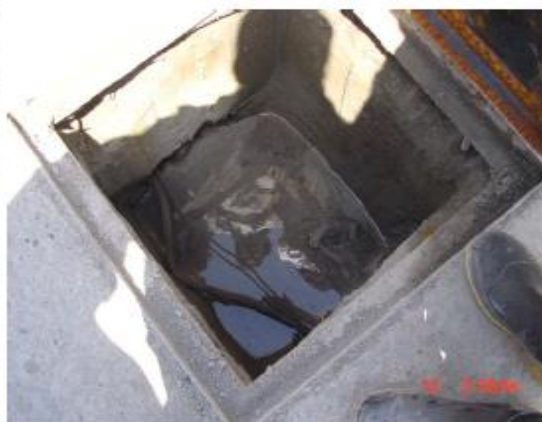
تصویر شماره ۵: محل جمع آوری و اندازه گیری دبی زهکش
