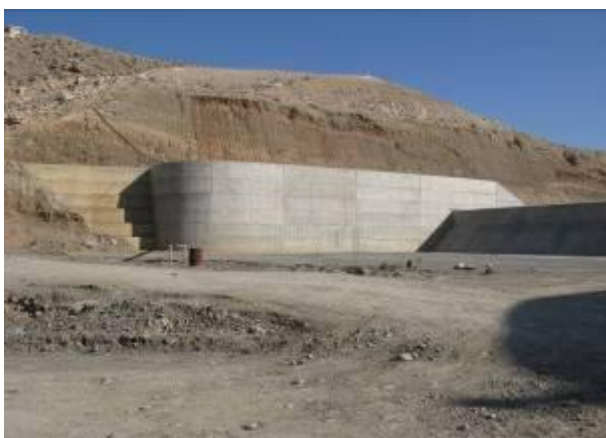
تصویر شماره ۲۲: ورودی سرریز سد و توده ناپایدار بالای آن
