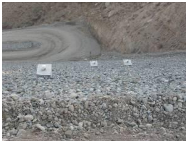
تصویر شماره ۱۳: عدم نصب پلکان برای دسترسی به ابزار دقیق
