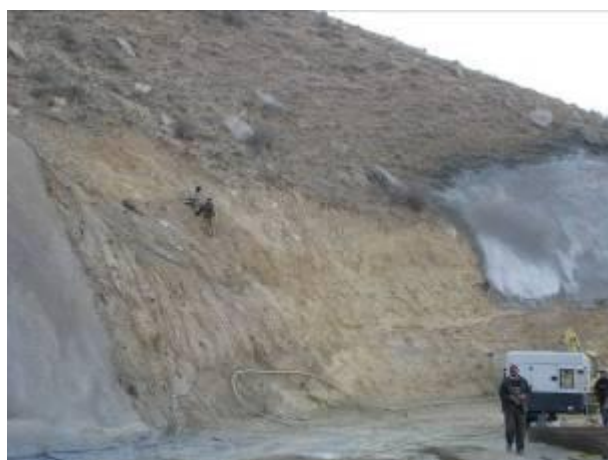
تصویر شماره ۱۲: نمای اجرای عملیات شاتریت
