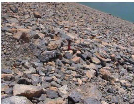
تصویر شماره ۵: نمای از پوشش سنگی بالادست
