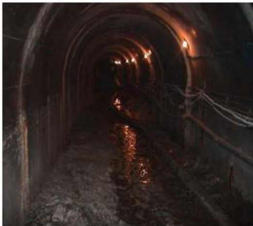
تصویر شماره ۲: گالری زهکش و نشت به علت عدم تکمیل تزریق
