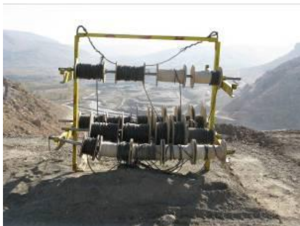
تصویر شماره ۱۴: کابل های ابزار در ناحیه تاج سد
