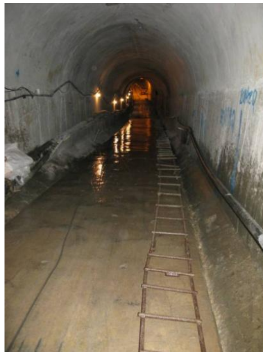
تصویر شماره ۲۵: وضعیت پله موقت و عدم نصب هندریل در گالری
