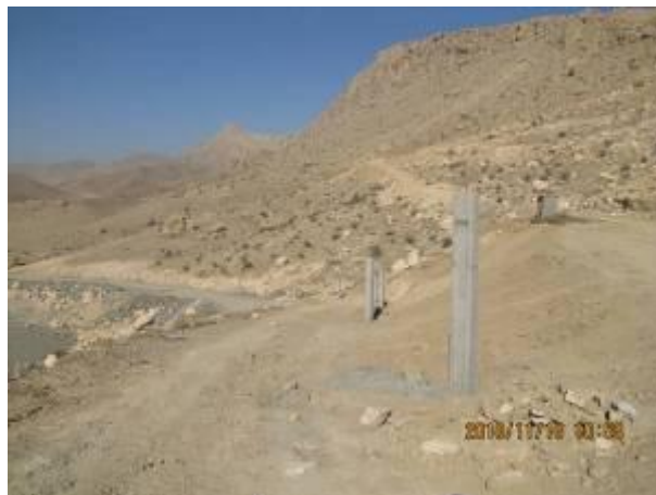
تصویر شماره ۱۷: نمای اشل مخزن و عدم نصب خط کش فلزی
