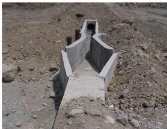
تصویر شماره ۵: محل جمع آوری و اندازه گیری دبی زهکش
