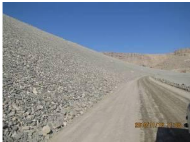
تصویر شماره ۱۹: رمپ سد و عدم اجرای آسفالت و گاردریل در آن
