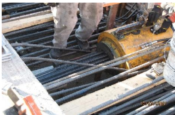
تصویر ۱۲- جک کشش فولادها
