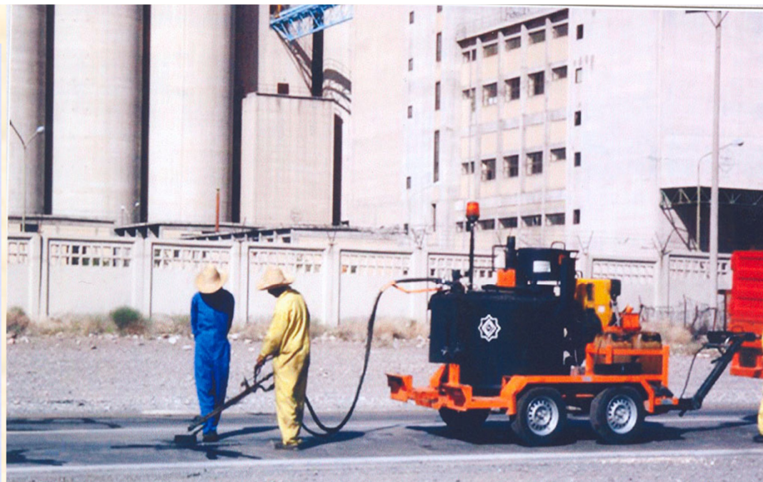
تزریق مواد درزگیر به داخل ترک تا عمق مورد نیاز
