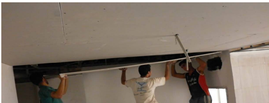
جاگذاری پنل برای نصب پیچ
