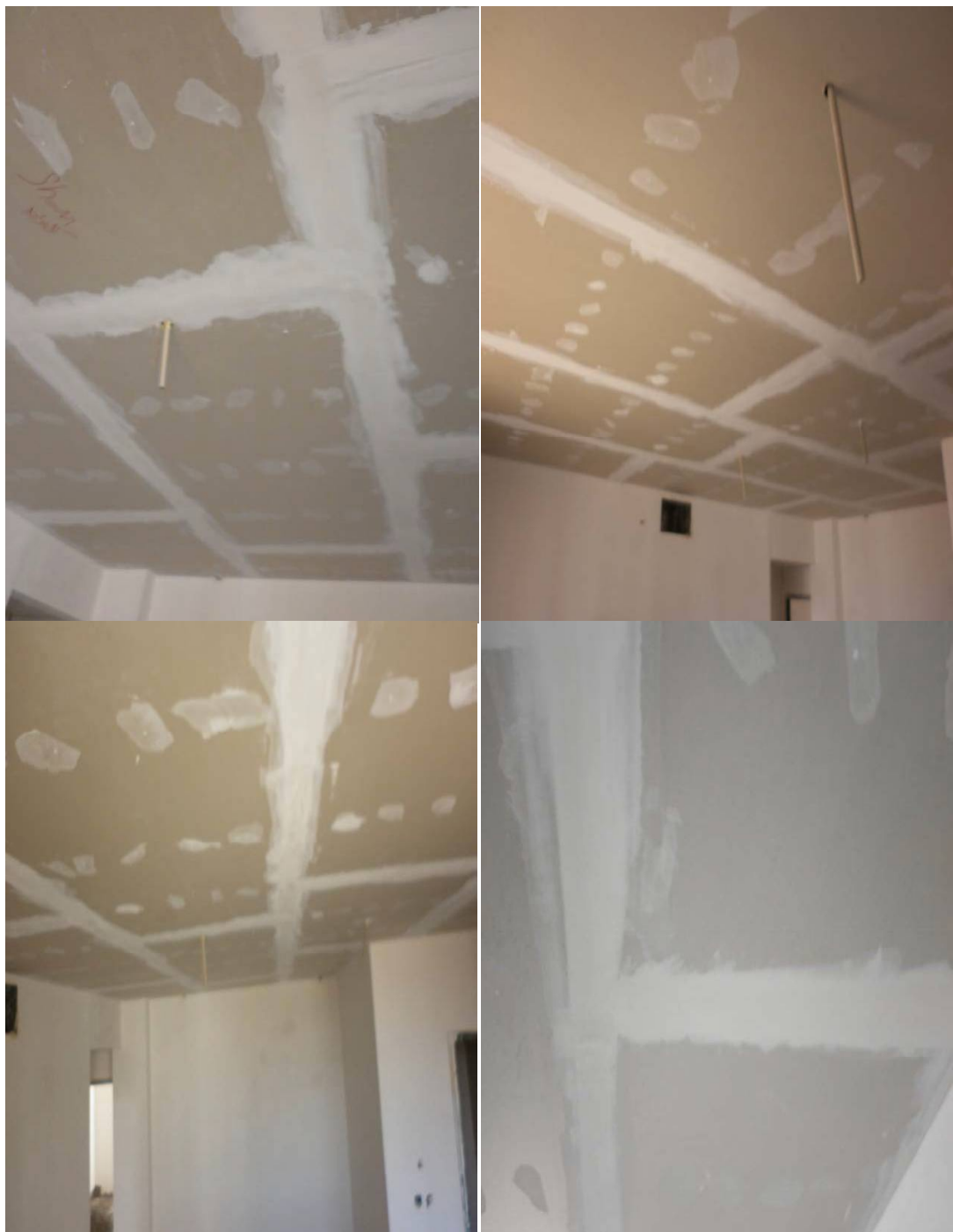
-نمونه کارهای درزگیری پس از اتمام تمامی مراحل-
