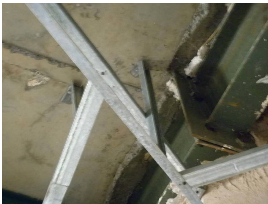
نحوه اتصال در گوشه ها و شکست هندسی
